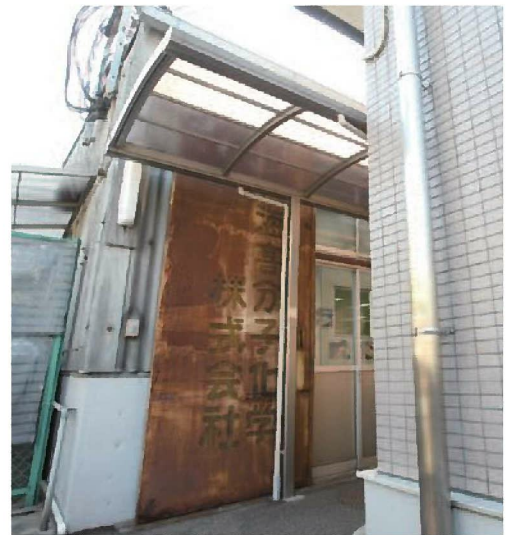
かつて東海高分子化学の一角にあった実験室。筒井さんが新素材開発に悪戦苦闘した思い出の場所だ。いまは、カテーテルの製造工場として使われている
